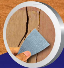
อุดรอยแตก ร่องไม้
